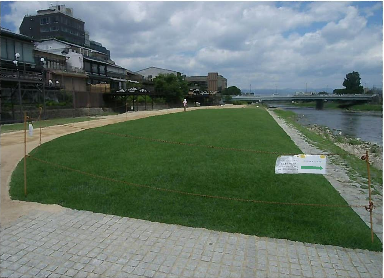
平成26年7月25日 シグママット設置・養生状況
