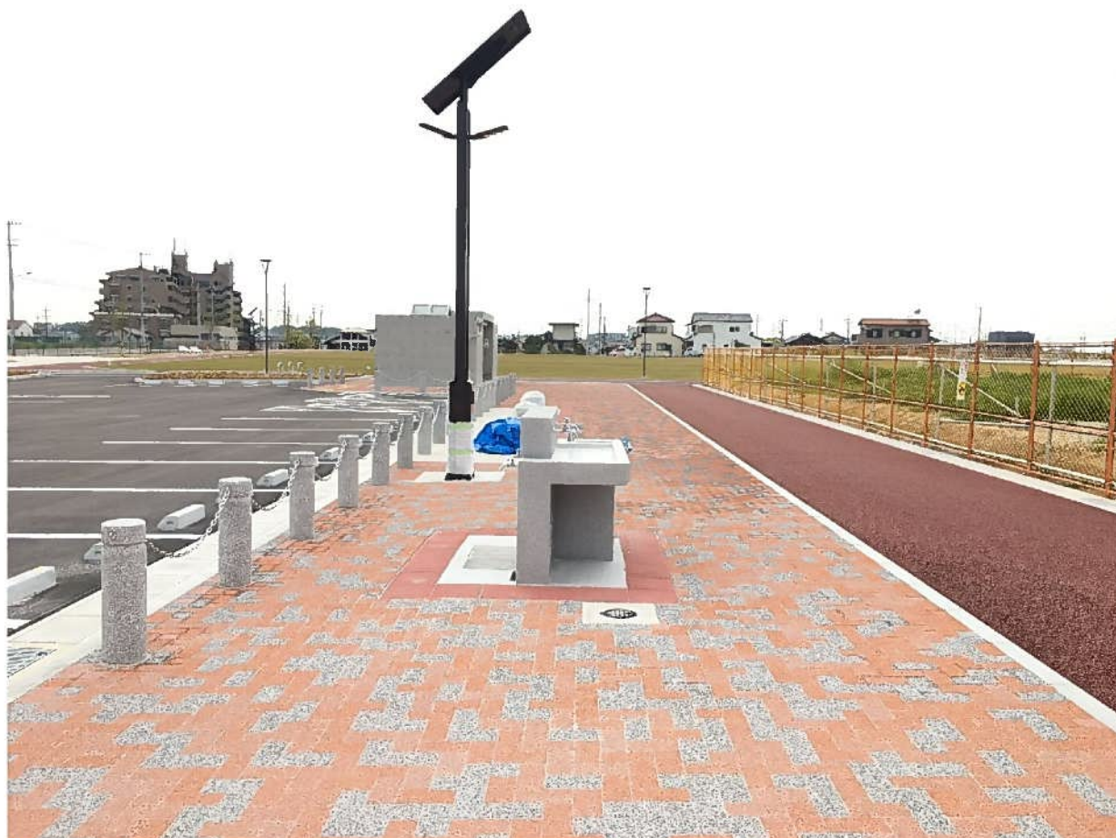
愛知県武豊町 武豊中央公園（防災公園）
