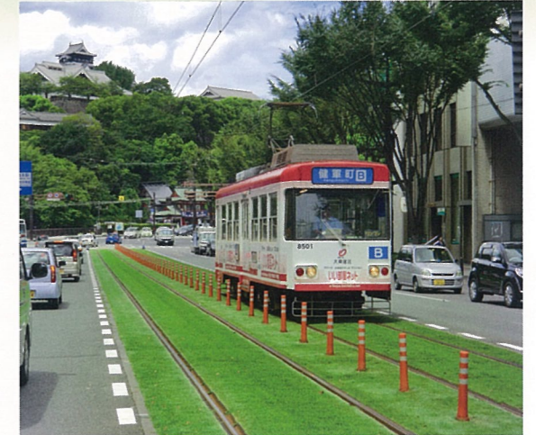
熊本市電通町筋電停軌道敷緑化
