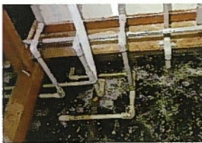
下部処理槽内
