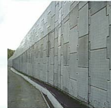
▲国道13号線 主要坂地区(山形県最上郡金山町中田地区)
