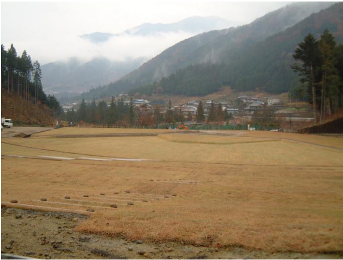
施工中 2005 年 1 2 月 2 日
