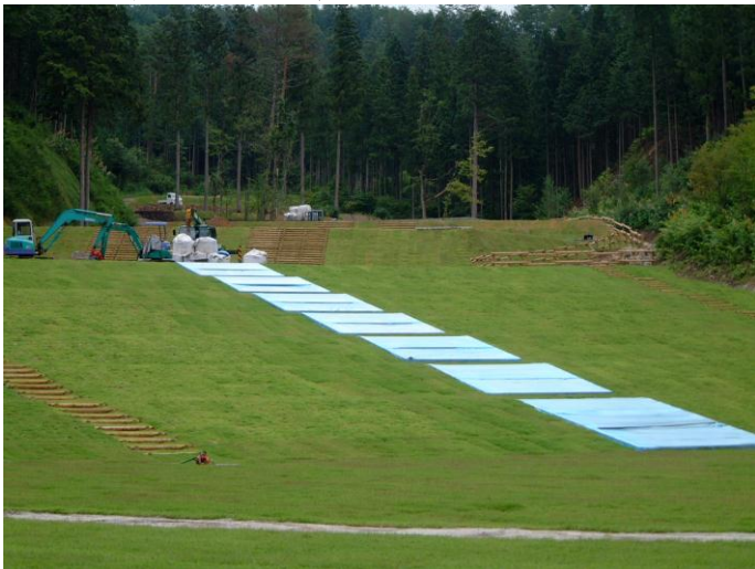
施工中 2005年 7月26日
