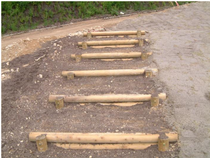
施工中 2005年 6月15日
