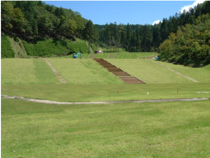
施工中 2005年 9月12日
