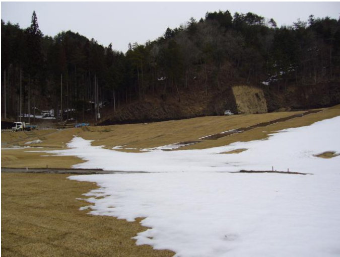
施工中 2006 年 2 月 2 4 日
