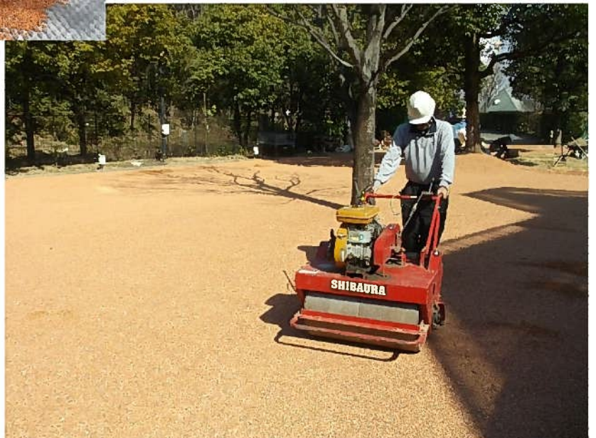
ピースマルチ敷き込みと転圧
